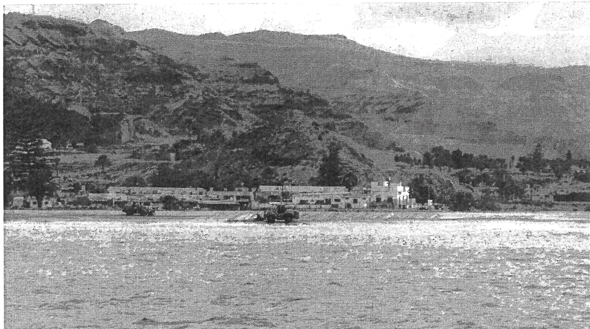
9.- Tractores a pie de playa, extendiendo la arena foránea a lo largo de la playa en la obra de mejora de la Playa de Tauro.
